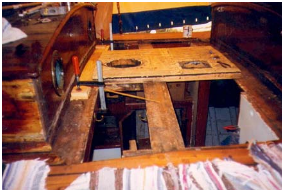
Klart for legging av nytt dekk mellom kappene
