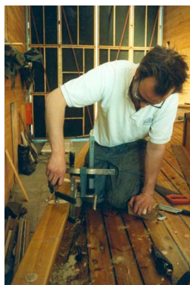
Rekka er montert til støttene med relingspiker. Begge deler er laget i eik
